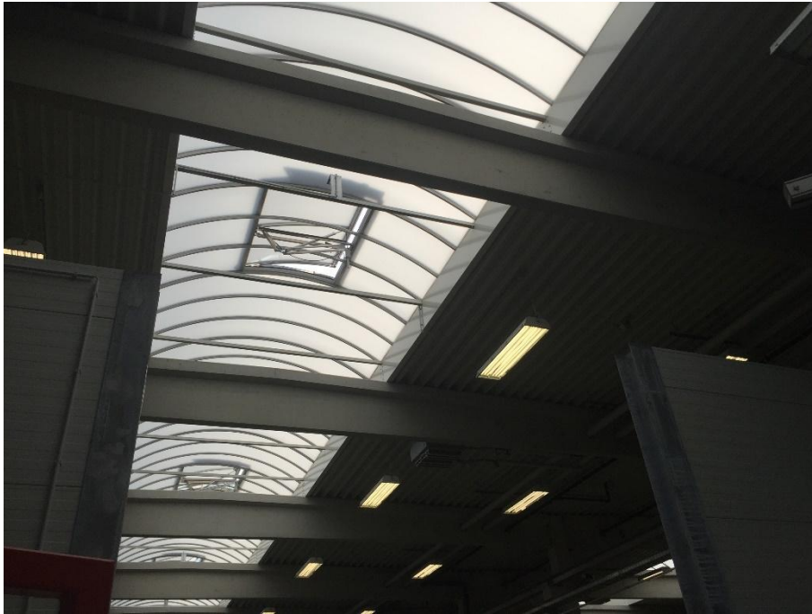
Abbildung 7: Beleuchtung Werkhalle mit Oberlicht
